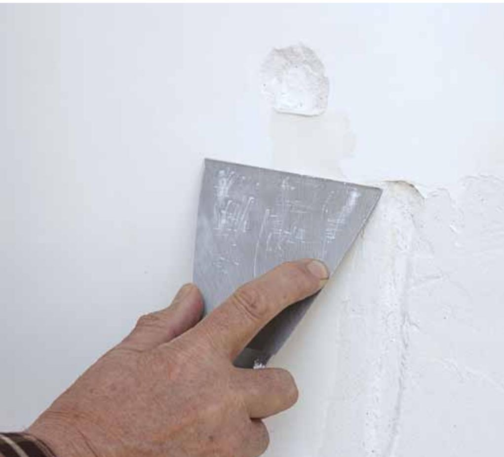
Applicazione di riempimento di cavità con una spatola (6-7 cm) sopra un fondo di gesso o pittura tradizionale
