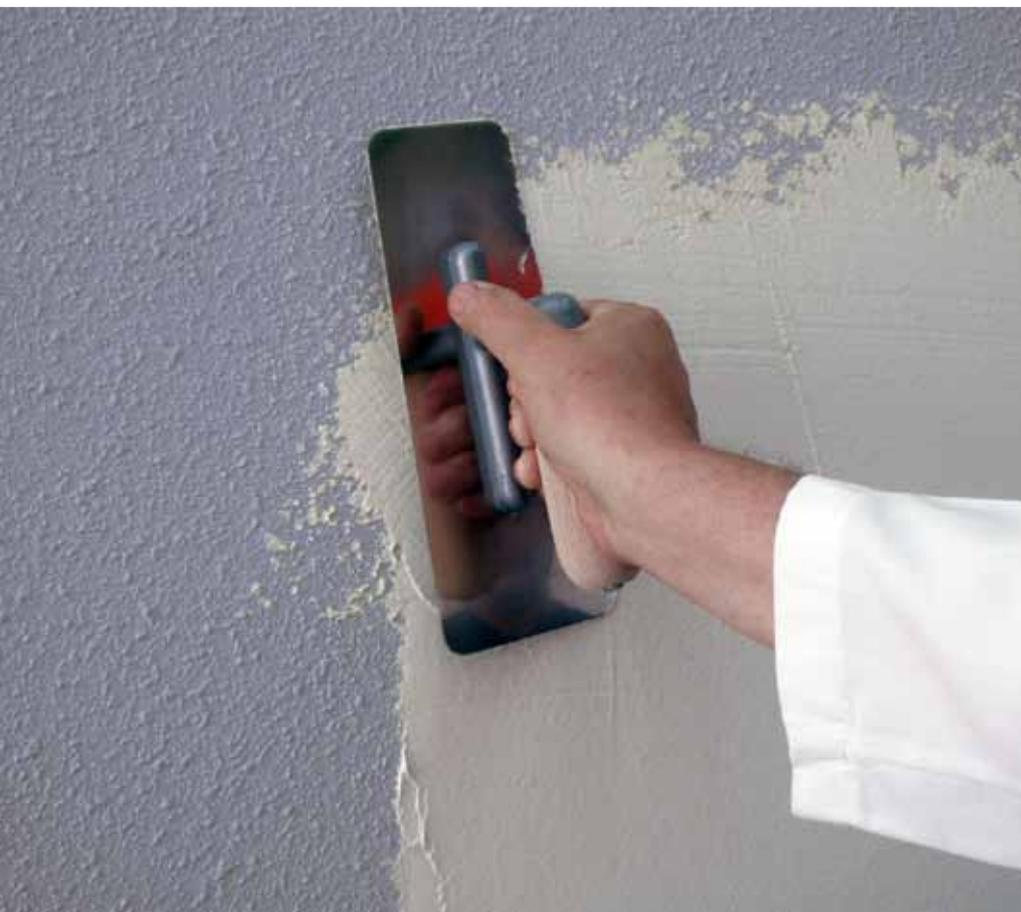
Rasatura con frattone di dimensioni medie (20-22 cm.) sopra un fondo di cemento pitturato con pittura tradizionale
